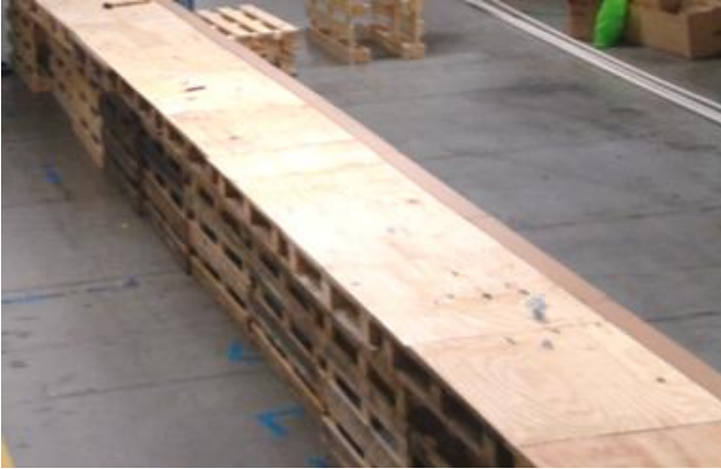
Figura 18: Foto da construção de um mockup na fase inicial
