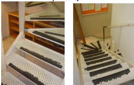
Figuras 137 e 138 - Escada de acesso ao estoque e demais ambientes de apoio da loja A
