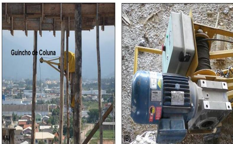
Figura 50. (A) Guincho de Coluna - Obra B – (B) Detalhe do motor do guincho de coluna – Obra C.
