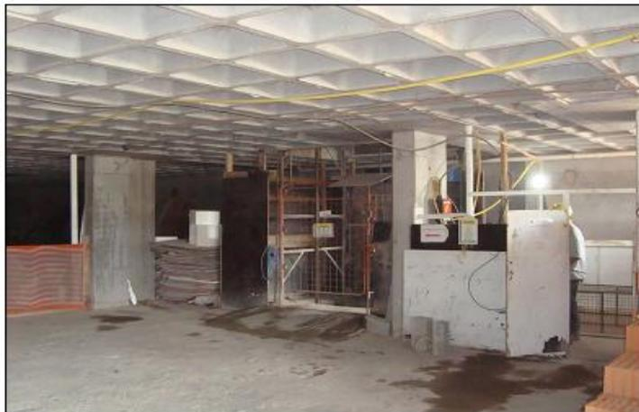
Figura 47. Laje nervurada – Obra B.
