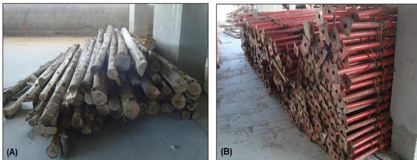
Figura 45. (A) Escora de eucalipto - Obra F – (B) Escora Metálica – Obra C.
