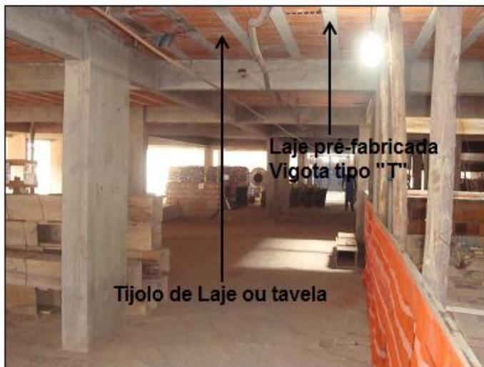
Figura 48. Laje pré-fabricada e tabelas – Obra D.
