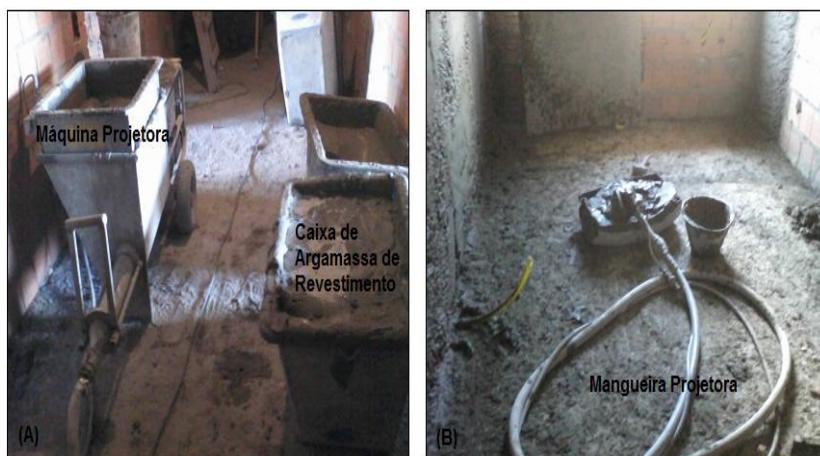
Figura 54. (A) Máquina Projetora – Obra C – (B) Mangueira projetora acoplada a máquina projetora.
