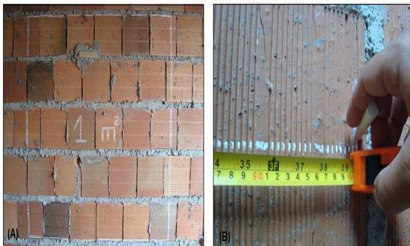
Figura 51. (A) Esquadro de destacado por giz branco – (B) Medição de 1m linear na horizontal.
