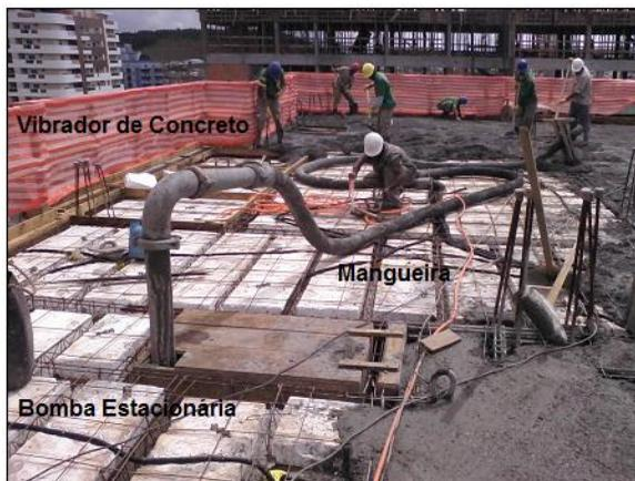
Figura 38. Concretagem da laje, vigas e pilares do Pavto Tipo da Obra “F”.
