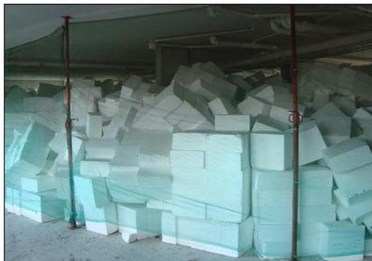
Figura 46. Blocos de EPS estocados – Obra C.
