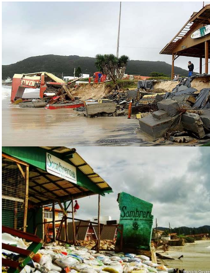
Figura 3: Efeitos decorrentes da ressaca que atingiu a praia da Barra da Lagoa em maio de 2010. Bares, casas e estruturas públicas foram danificados. (Foto: Cesar Carvalho e Marcelo Gevaerd).
