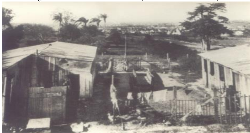
Figura 2 – Colônia Africana - 1922 (atual Bairro Rio Branco)
