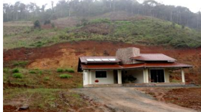
Fig. 69 – Construção recente no Braço do Baú feita sob o sistema de corte e aterro. Foto: PARIZOTO, D. G. V. (2011).
