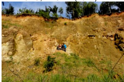
Fig. 95 – Visão geral do talude formado pelo deslizamento. Foto: PARIZOTO, D. G. V. (2012).
