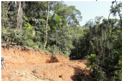
Fig. 66 – Corte em área de declive para abertura de caminhos. Foto: PARIZOTO, D. G. V. (2011).
