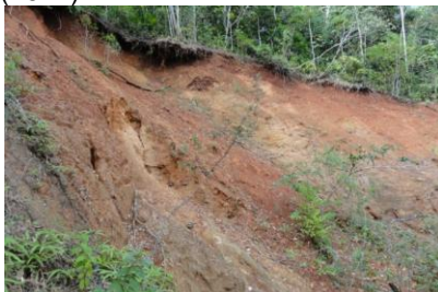
Fig.123 – BAÚ 02 – Encosta com ângulo de 33 graus ( \approx 65\% ). FS = 1,342.
