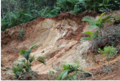
Fig.118 – BAÚ 01B – Encosta com ângulo de 33 graus (≈ 65%). FS = 1,536.
