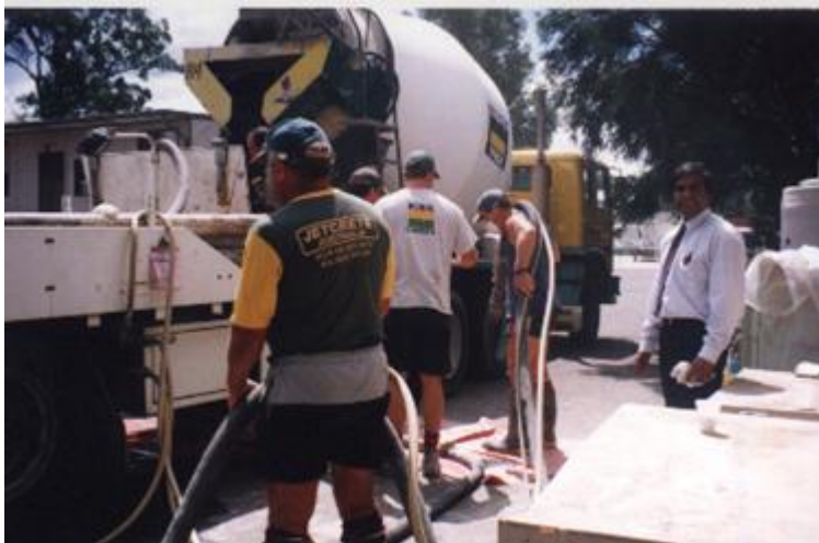
Figura 7 – Concreto sendo bombeado do caminhão betoneira para ser jateado nos moldes
