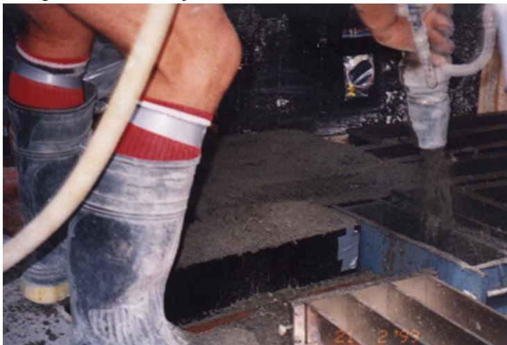
Figura 8 – Processo de jateando do concreto diretamente nos moldes
