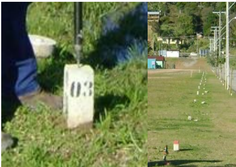
Figura 48: Marco de concreto dos pontos limites legais das parcelas 12-08-2013 (Fonte: o autor).
