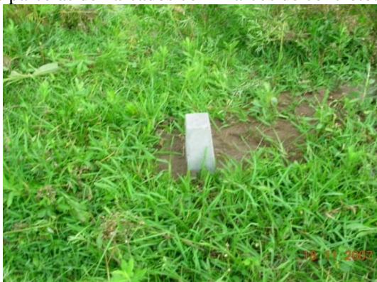
Figura47: Marco de concreto dos pontos limites legais das parcelas 12-08-2013 (Fonte: o autor).
