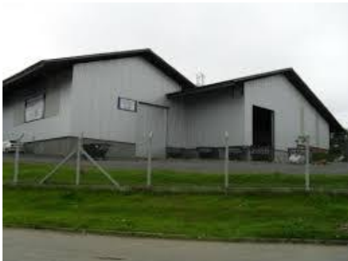
Figura 7: Foto da fachada do barracão da associação. Fonte: internet.
