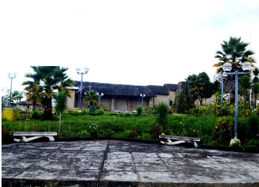
Figura 12: Igreja de San Carlos vista desde a praça central.
