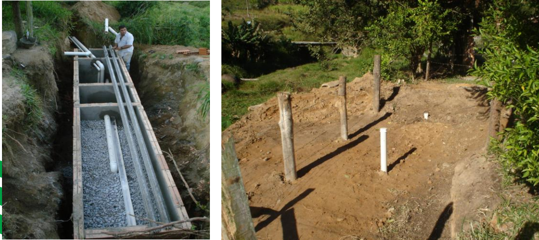
Figura 11. Sequência da instalação do sistema ABNT
