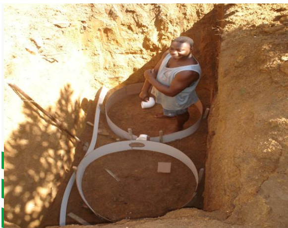
Figura 16. Instalação do Reator Unicamp duplo com areia
