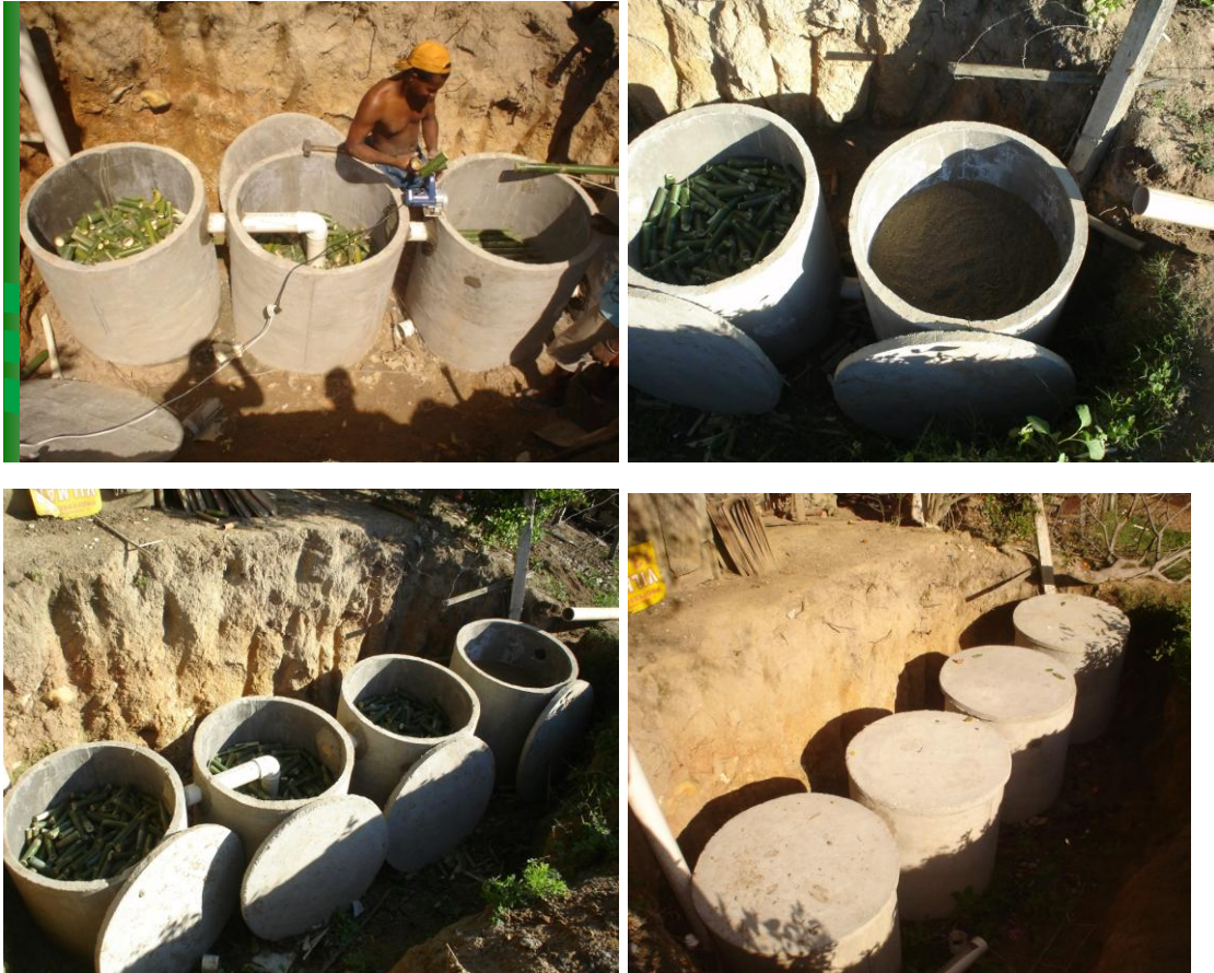
Figura 12. Sequência da instalação do sistema Laranja
