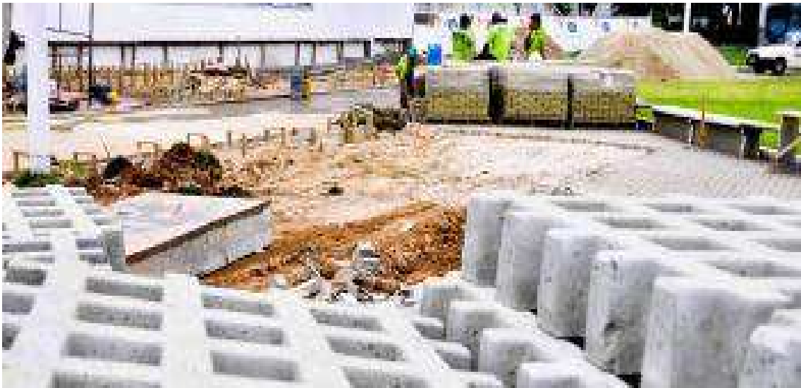
Figura 8 - Praça do Rotary Club em obras
