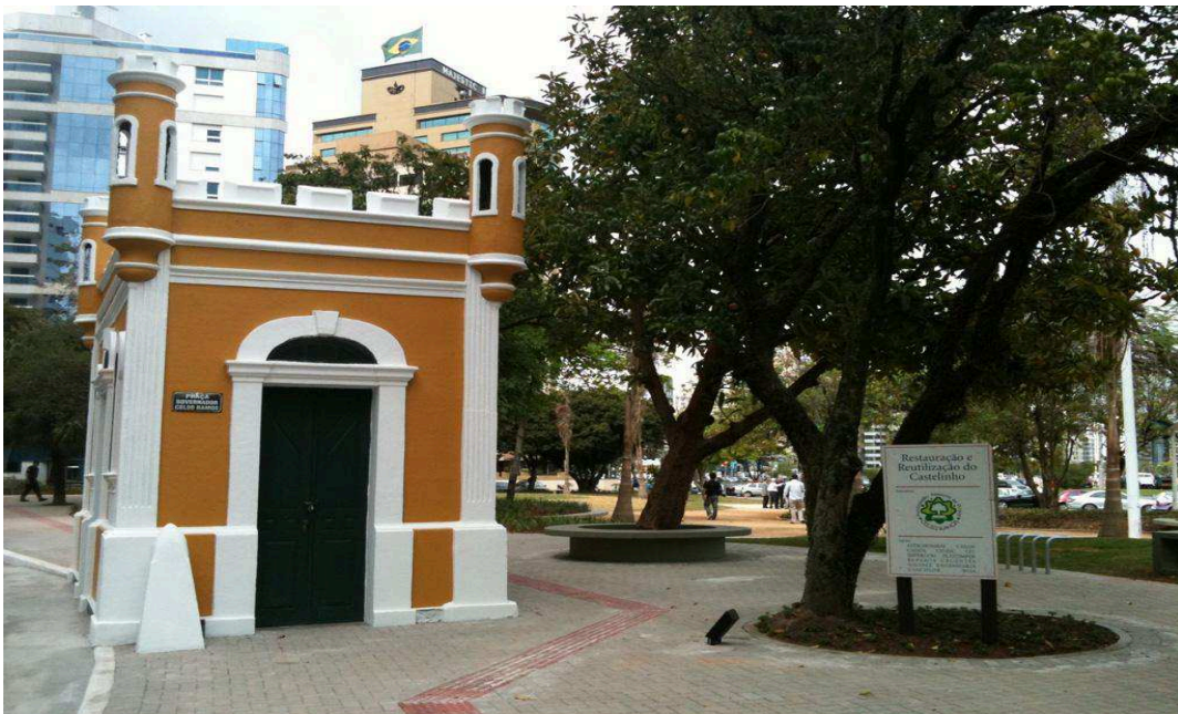
Figura 5 - Estação Elevatória Praça Governador Celso Ramos revitalizada
