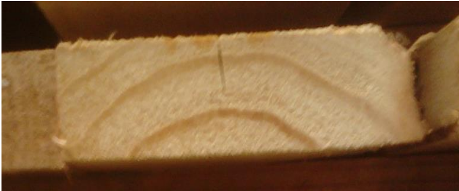
Figura 5. Trinca de topo ocorrido por conta da secagem.
