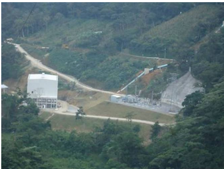
Figura 7 - PCH Veracruz - Casa de Força e Subestação. (Foto: Engevix SA)
