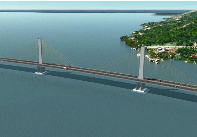
Figura 4 - Ponte da Travessia de Cabeçuda e Canal de Laranjeiras, detalhe na parte estaiada
