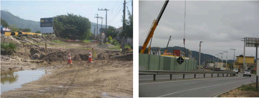
A - Atividades e mobilização para construção do desvio. B – desvio concluído
