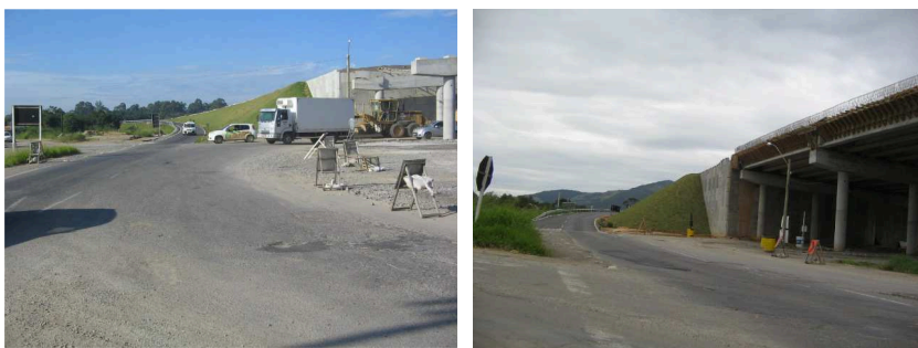
Figura 20 - Ocorrência de Irregularidade – Ausência de Sinalização – Programa de Redução do Desconforto e Acidentes na Fase de Obras – lote 1.
