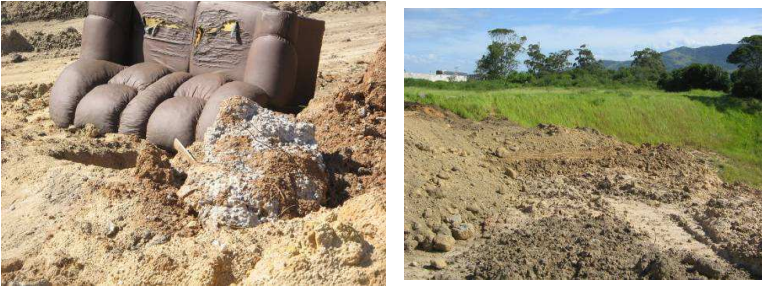
a) Situação inadequada o descarte inadequado de lixo doméstico no bota-fora
