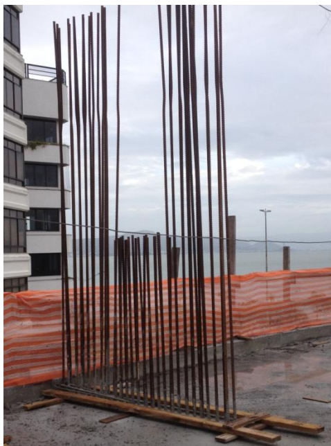
Figura 32 –Montagem de Armação
