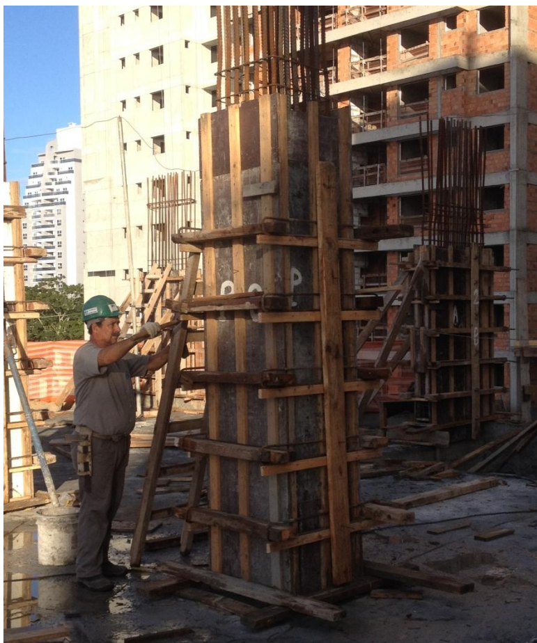
Figura 15 – Montagem de Fôrmas de Pilar
