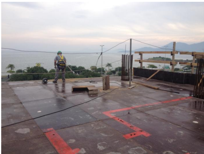
Figura 18 – Montagem de Fôrmas de Laje
