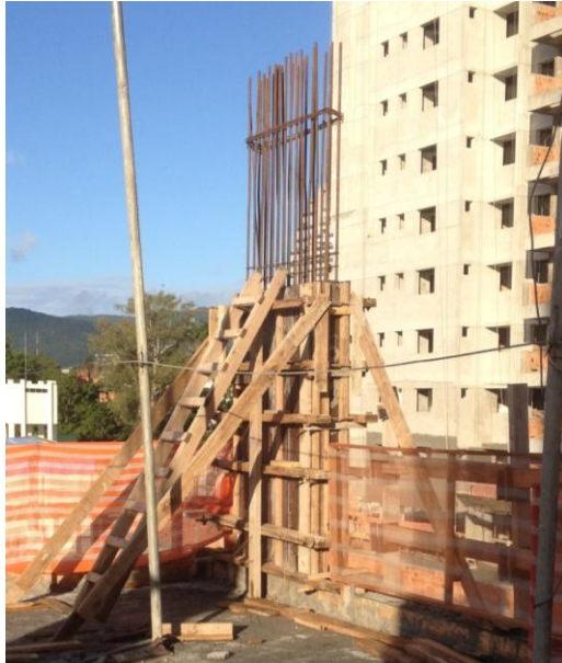
Figura 13 - Montagem de Fôrmas de Pilar
