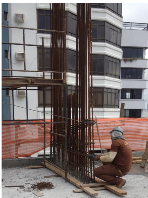
Figura 33 – Montagem de Armadura
