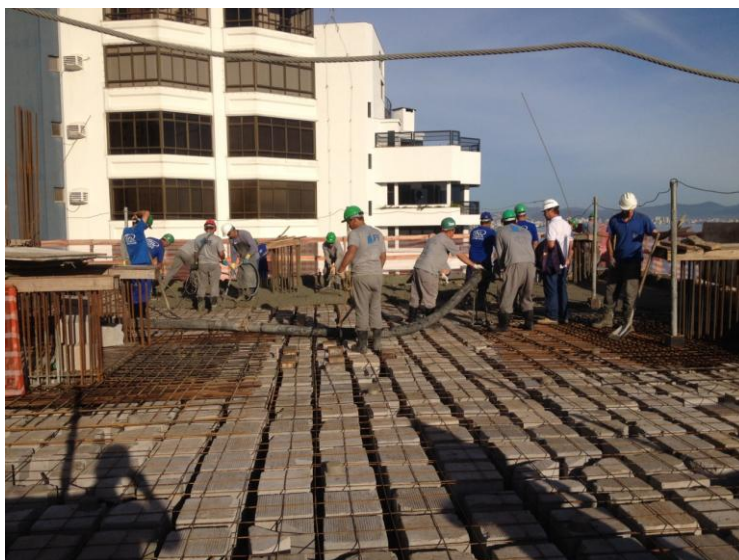
Figura 45 – Concretagem de Laje
