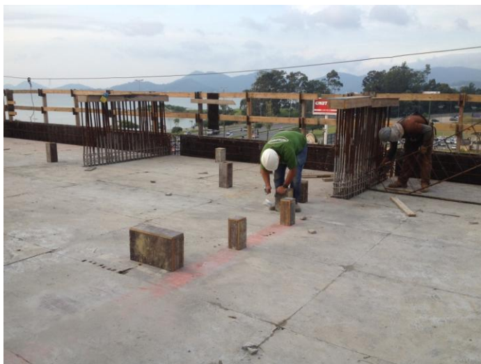
Figura 36 – Montagem de Armação – Detalhe de execução de caixas de passagem
