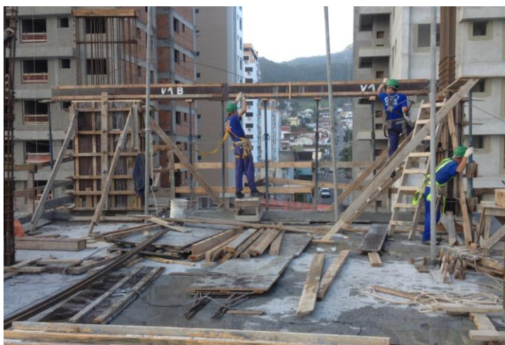
Figura 16 – Montagem de Fôrmas de Vigas
