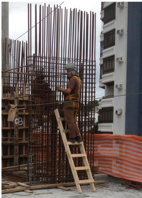
Figura 34 – Montagem de Armadura
