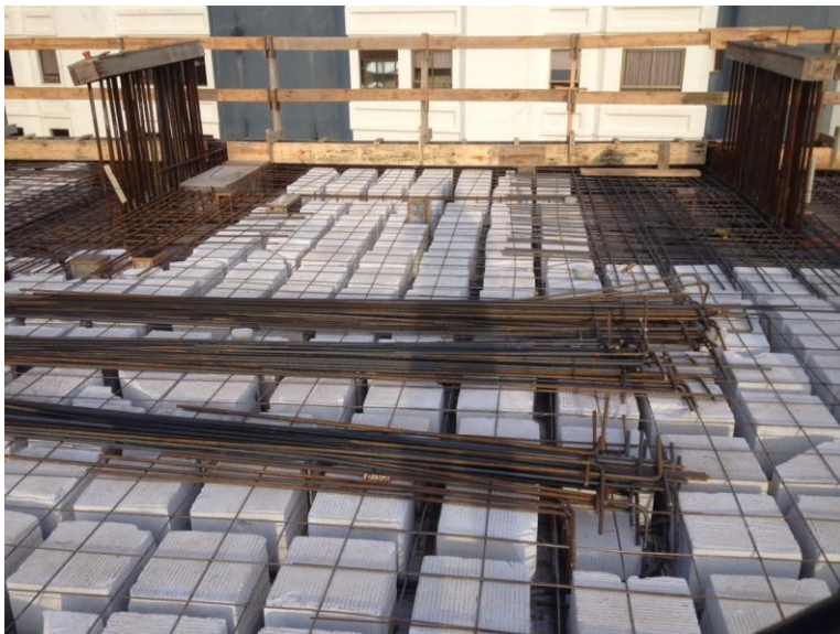
Figura 37 – Montagem de Armação – Detalhe de execução
