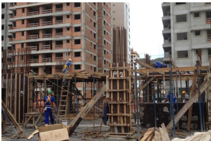
Figura 17 – Montagem de Fôrmas de Vigas e Laje
