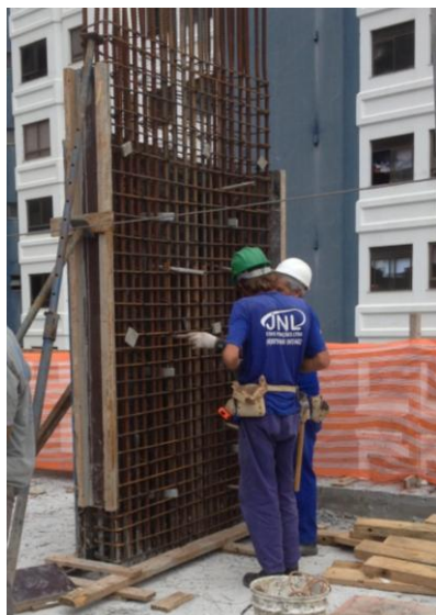
Figura 14 – Montagem de Fôrmas de Pilar
