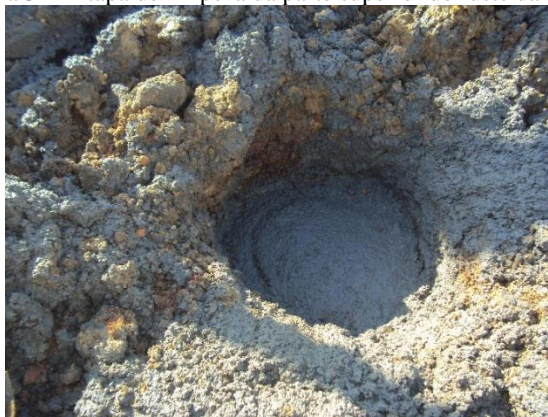
Figura 31 - Etapa de limpeza da parte superior do fuste da estaca
