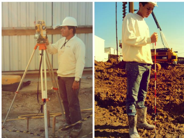
Figura 24 - Levantamento topográfico e locação do eixo das estacas
