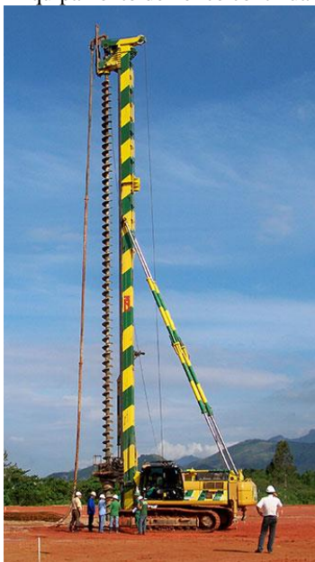
Figura 15 – Equipamento de hélice contínua monitorada
