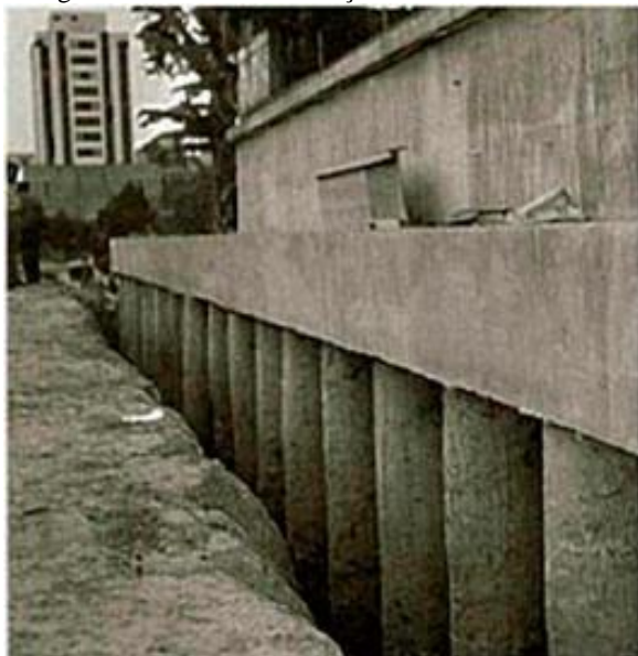
Figura 21 - Muro de contenção com hélice contínua
