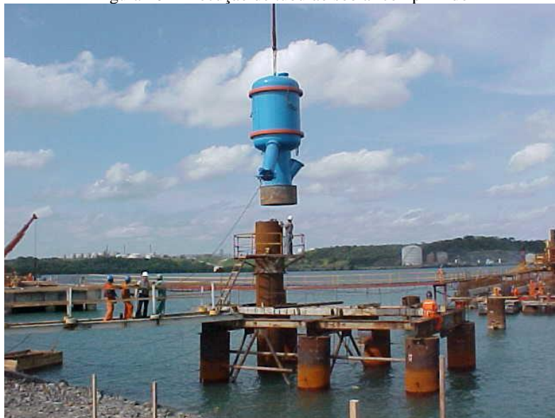
Figura 20 - Execução de tubulão sob ar comprimido
