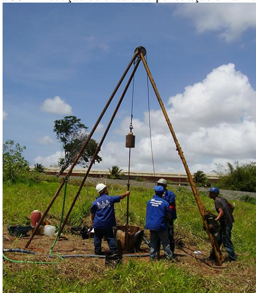
Figura 58 - Execução de ensaio de penetração dinâmica SPT
