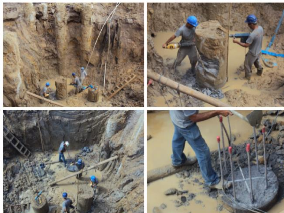
Figura 35 - Etapa de execução do arrasamento de estacas tipo hélice contínua monitorada (EHC)
