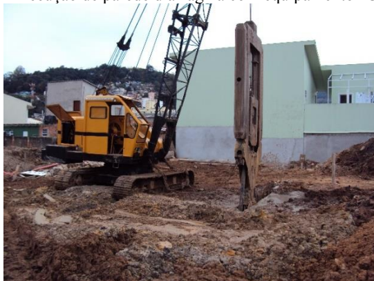
Figura 72 - Execução de parede diafragma com equipamento “Clam-Shell”
