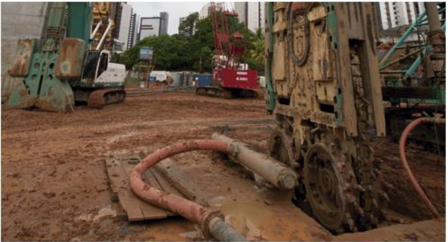
Figura 16 - Execução de fundação com estaca tipo Barrete
