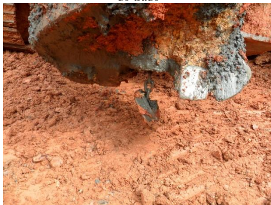
Figura 27 - Detalhe da tampa de proteção recuperável na extremidade inferior do trado
