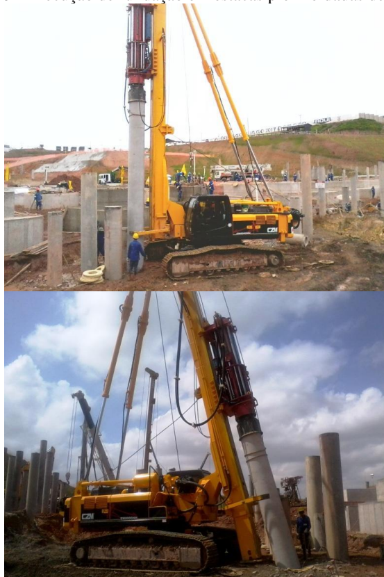
Figura 10 - Execução de fundação em estacas pré-moldadas de concreto
