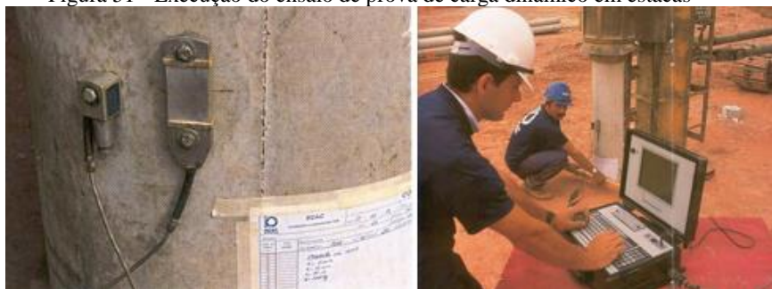
Figura 51 - Execução do ensaio de prova de carga dinâmico em estacas
