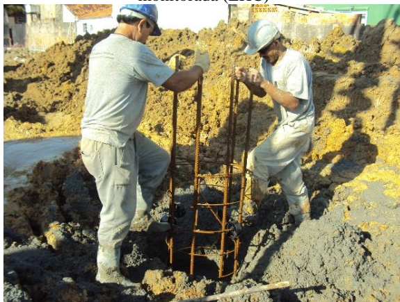
Figura 32 - Etapa de introdução da armadura na estaca tipo hélice contínua monitorada (EHC)
