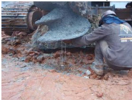
Figura 25 - Posicionamento do eixo da hélice no ponto de locação
