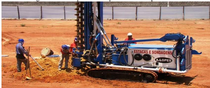
Figura 14 - Execução de fundação com estaca tipo Broca
