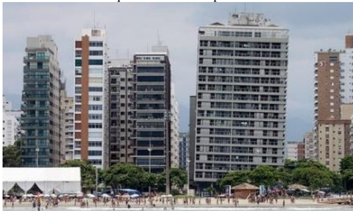
Figura 64 - Caso de recalque diferencial em prédios da cidade de Santos-SP
