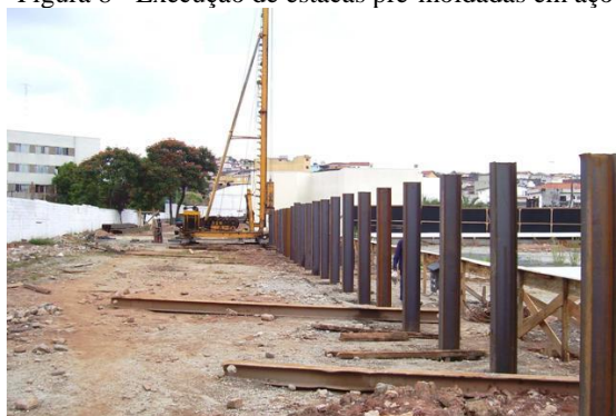
Figura 8 - Execução de estacas pré-moldadas em aço
