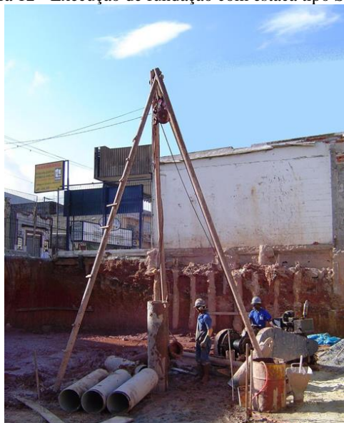
Figura 12 - Execução de fundação com estaca tipo Strauss
