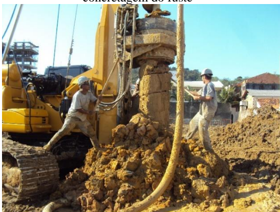
Figura 30 - Etapa de extração e limpeza do trado concomitantemente à concretagem do fuste
