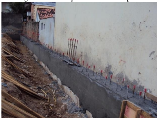
Figura 73 - Viga de solidarização das lamelas da parede diafragma
