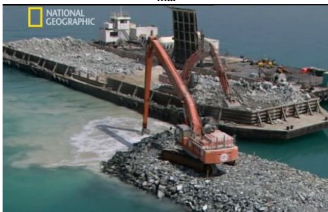
Figura 30 – Batelão e guindaste atuando em conjunto na construção de quebra-mar
