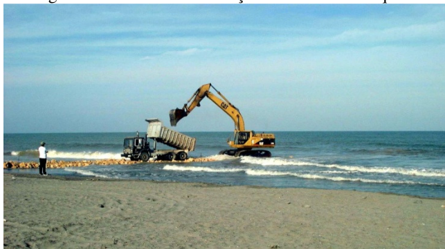
Figura 27 – Início da construção de aterro de conquista
