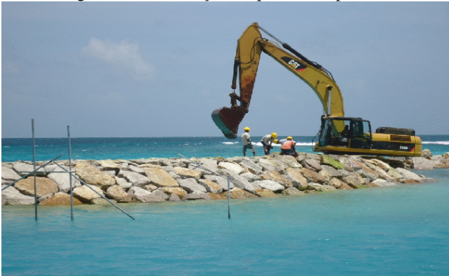
Figura 28 – Construção de quebra mar por terra
