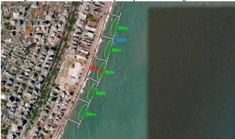
Figura 3 – Estruturas projetadas para a praia de Boa Viagem - Recife
