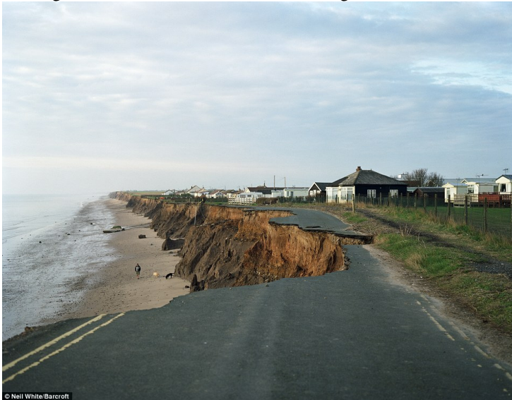
Figura 42 – Erosão costeira em East Riding of Yorkshire, UK
