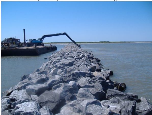
Figura 29 – Construção de quebra-mar através de guindaste embarcado
