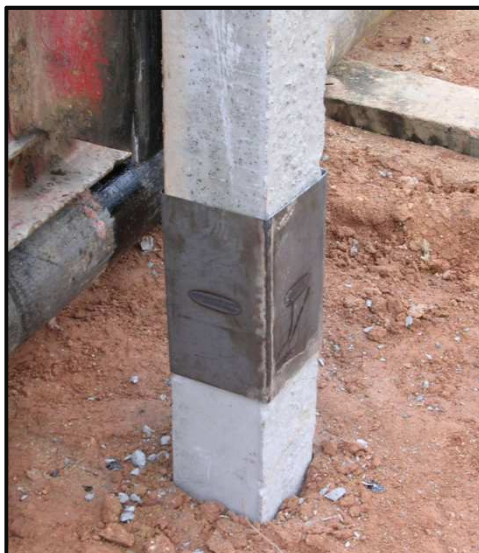
Figura 2.11 - Emenda por luva de encaixe.
