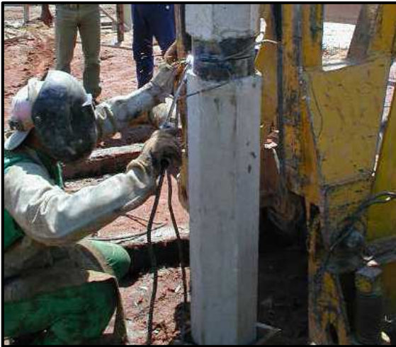
Figura 2.10 - Emenda soldada.
