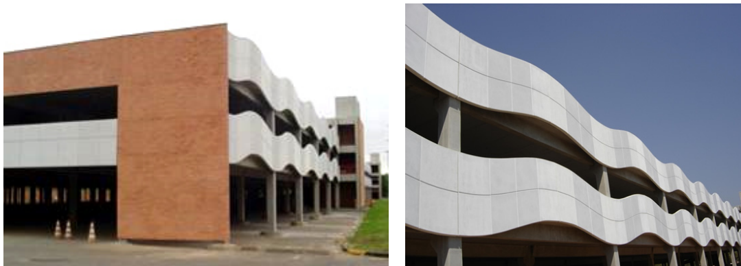
Figura 47 a- Fachadas do Estacionamento da Ulbra com painéis pré-fabricados e b- painéis de GRC fabricados com cimento branco projetados especialmente para as fachadas do Estacionamento da Universidade Luterana do Brasil em Canoas. 2006.
