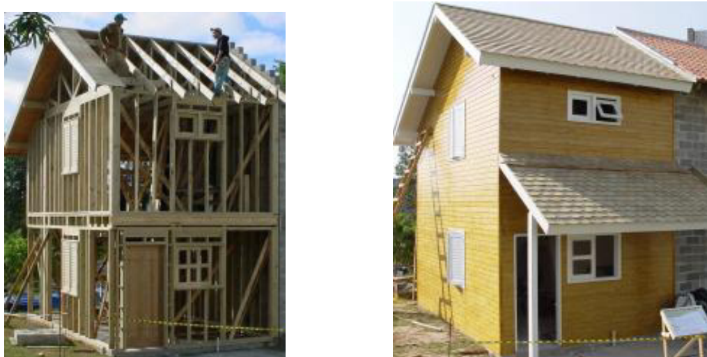
Figura 23 a – construção da estrutura do protótipo da pesquisa FINEP–CNPq em parceria com a empresa Batistella com sistema de madeira Tipo Plataforma e b- fase de finalização do casa unifamiliar no sistema construtivo Stella-UFSC.
