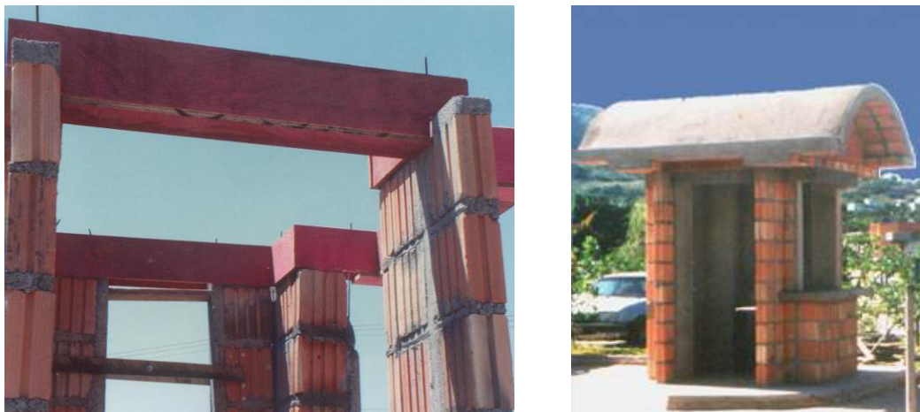
Figura 20 a- montagem dos elementos pré-fabricados com blocos cerâmicos estruturais e b- fase de finalização da guarita construída com a tecnologia da Alvenaria Armada.
