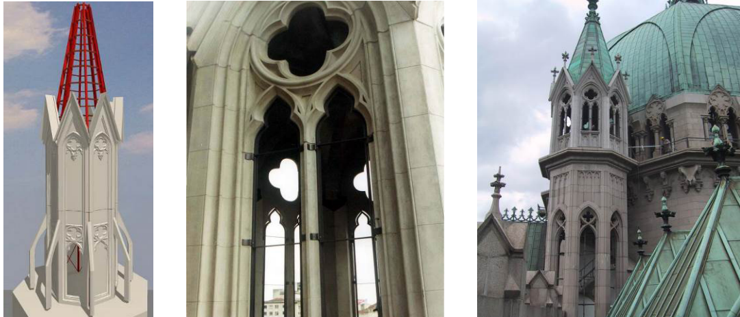
Figura 45 a- modelo tridimensional da torre, b- montagem dos painéis de GRC e c- finalização das 14 torres da Catedral da Sé de São Paulo em 2002.
