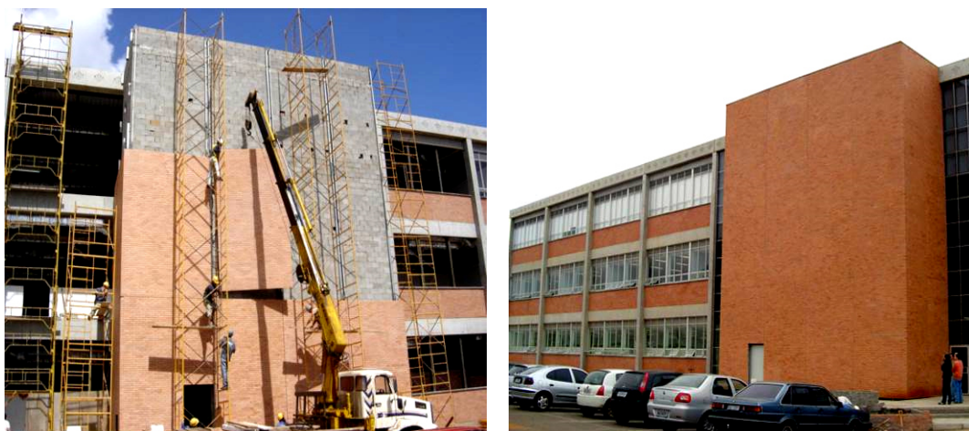
Figura 46 a- montagem de painéis de GRC com revestimento cerâmico incorporado, b- edifício da Faculdade de Odontologia da Universidade Luterana do Brasil em Canoas. 2006.
