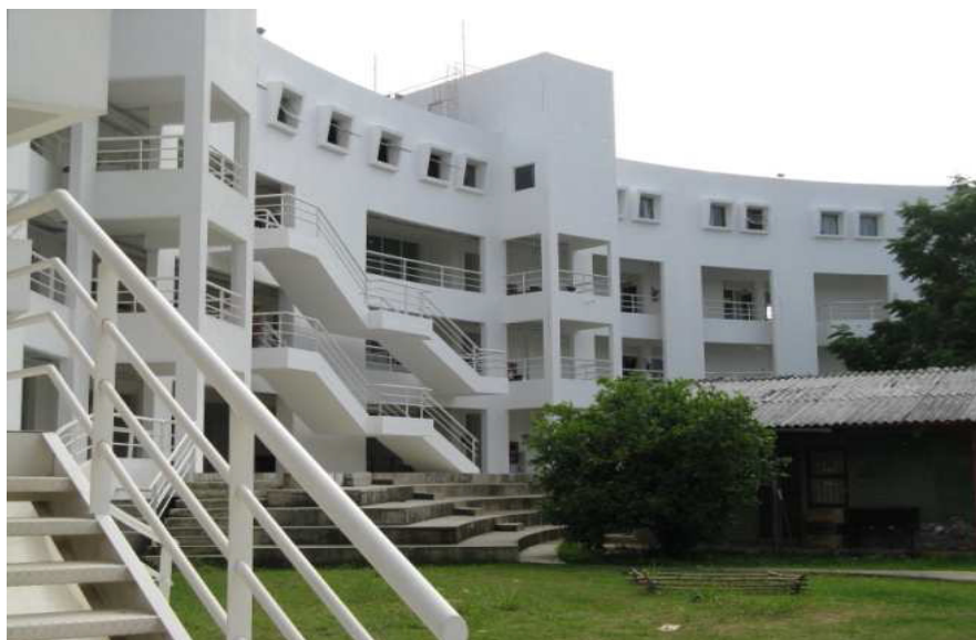
Figura 01 - Prédio Novo do Departamento de Arquitetura e Urbanismo da UFSC em que atuei na fase de viabilização e coordenação dos projetos complementares.
