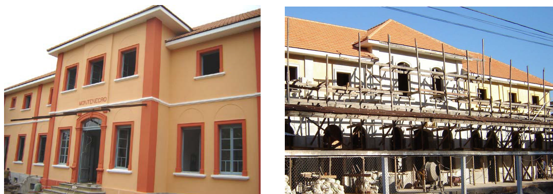
Figura 55 a – Restauração da fachada principal da antiga Estação Ferroviária de Montenegro, RS e b- obras de de restauração da fachadas posterior em 2006.
