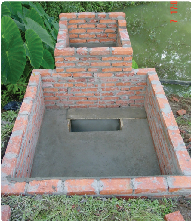
Figura 22. Foto da construção do reservatório de lavagem e foto do filtro terminado
