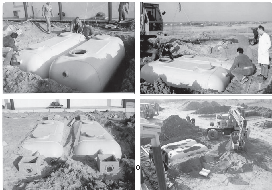
Figura 12: Seqüência de fotos que ilustram a implantação de duas unidades em paralelo de tanque sépticos confeccionados em fibra (Acervo GESAD/ENS-UFSC).
