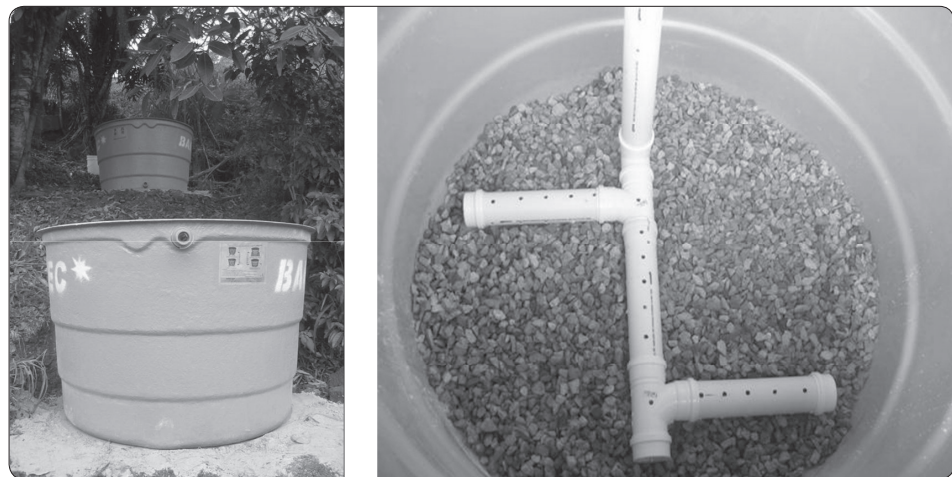
Figura 22: Foto da sequência de construção de um filtro anaeróbio de leito fixo com fluxo ascendente, adaptado em estruturas de caixas d'água de fibra (Acervo GESAD/ENS-UFSC).
