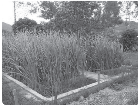
Figura 38: Foto de filtros plantados com macrófitas de fluxo horizontal aplicados ao tratamento de esgoto doméstico (Acervo GESAD/ENS-UFSC).
