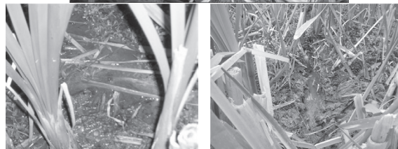
Figura 39: Fotos de empoçamentos gerados nos filtros plantados com macrófitas, indicando o início do processo de colmatção do material filtrante (Acervo GESAD/ENS-UFSC).
