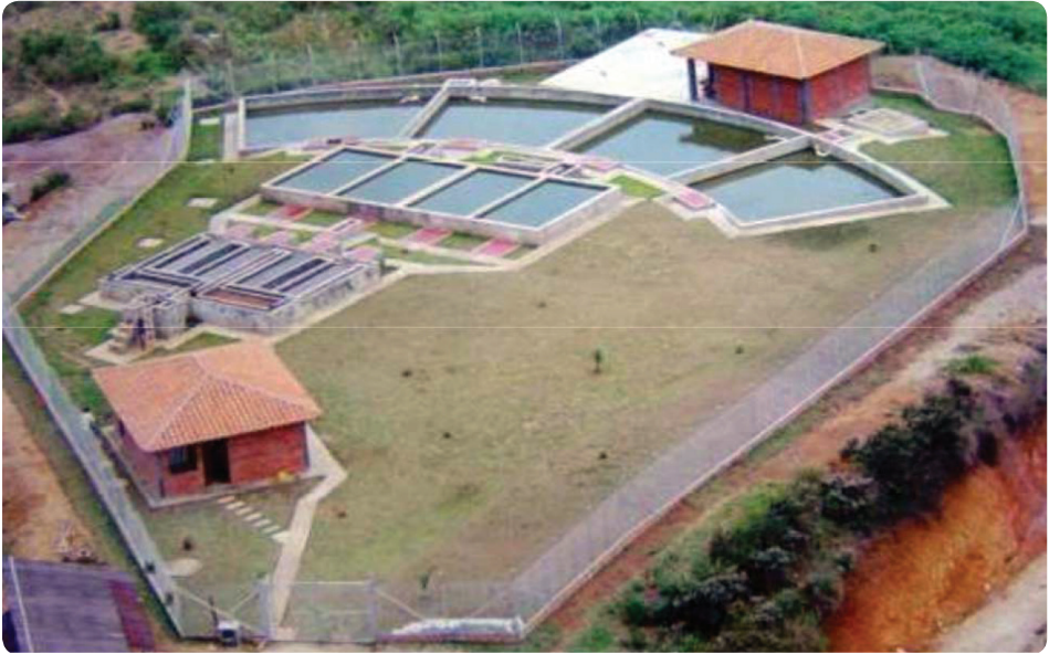
Figura 10. Foto de um sistema de filtração em múltiplas etapas em uma pequena comunidade em Cali, Colômbia.
