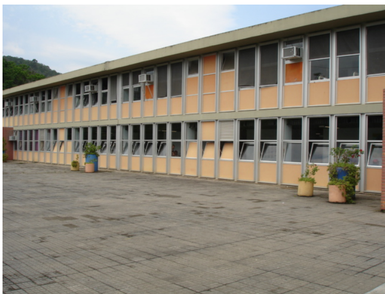
Figura 3.3: Vista externa do hospital
