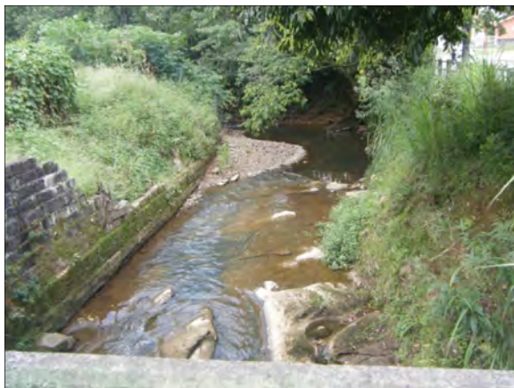
Figura 5 - Ponte sobre Rio Ferreira, montante ao norte
