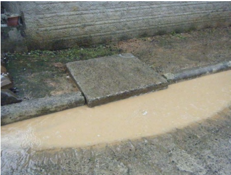
Figura 7 - Situação de uma boca de lobo no centro do município de Treviso
