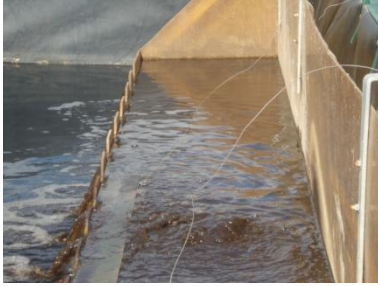
Figura 12 - Entrada do decantador secundário (P3)
