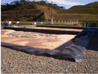
Figura 7 - Tanque de Aeração
