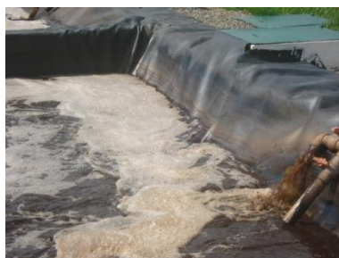
Figura 11 - Tanque de aeração (P2)
