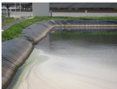
Figura 10 - Lixiviado aflúente (saída da Lagoa Anaeróbia 2 - P1)
