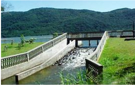
Figura 9 – Barragem que liga a Lagoa do Peri ao Canal Sangradouro. Fonte: CASAN, 2012.
