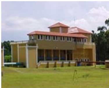
Figura 5 – Estação de Tratamento de Água da Lagoa do Peri. Fonte CASAN, 2009.
