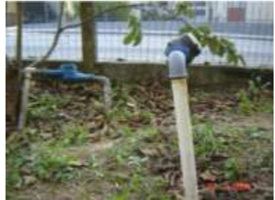
Figura 4: hidrômetros inclinados (erros de medição)
