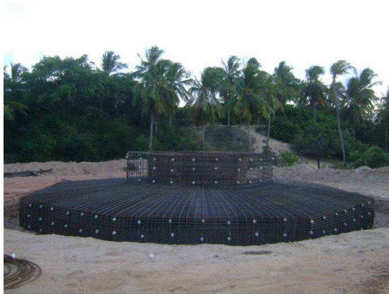
Figura 11: Armadura já executada
