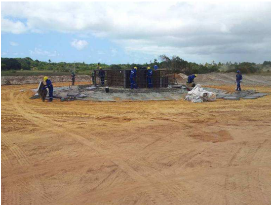
Figura 14: Reaterro de compactação de 1º estágio e forma de 2º estágio em andamento.
