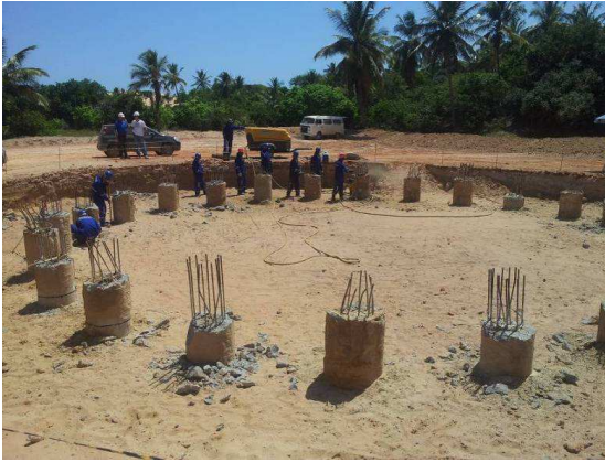
Figura 9: Estacas expostas após escavação da base.
