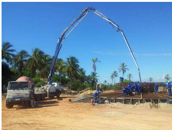
Figura 12: Concretagem de 1º estágio em andamento
