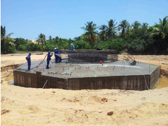
Figura 13: Concretagem da base concluída e procedimento de cura em andamento.
