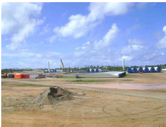
Figura 6: Pátio de estocagem de equipamentos, localizado no interior do canteiro de obras.
