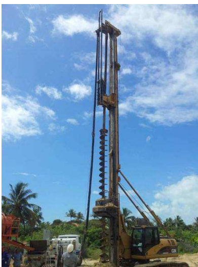
Figura 8: Execução de estacas profundas utilizando uma perfuratriz de hélice contínua.
