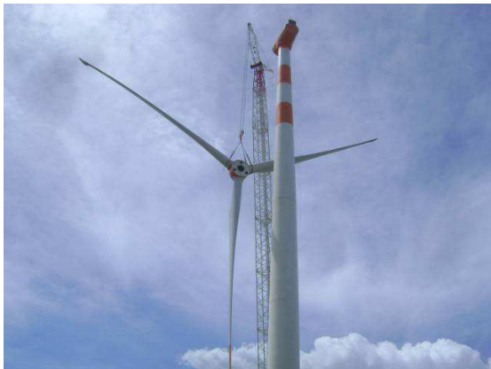
Figura 18: Içamento do conjunto das pás e hub.
