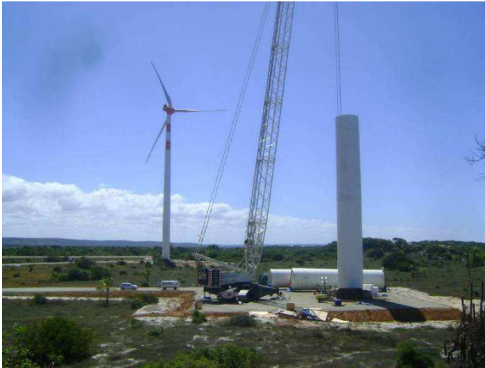
Figura 17: Vista da Base 20 com montagem da torre concluída e Base 16 com montagem do T3 em andamento.
