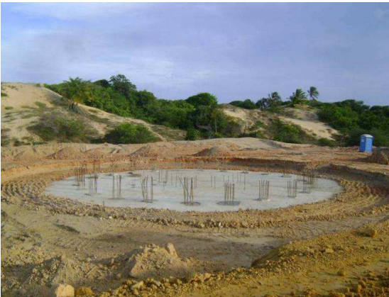
Figura 10: Base depois de concluídos o estaqueamento e regularização do piso.
