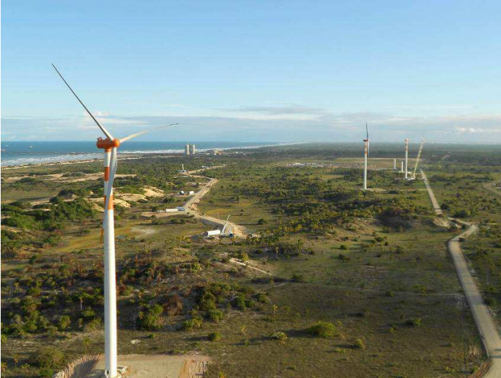
Figura 19: Vista aérea do parque com montagem dos aerogeradores em andamento.
