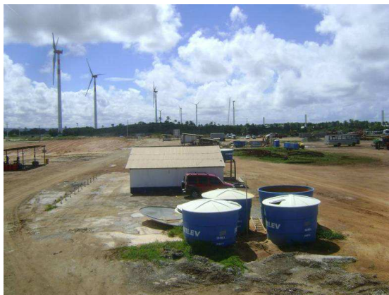
Figura 5: Vista parcial do canteiro de obra.
