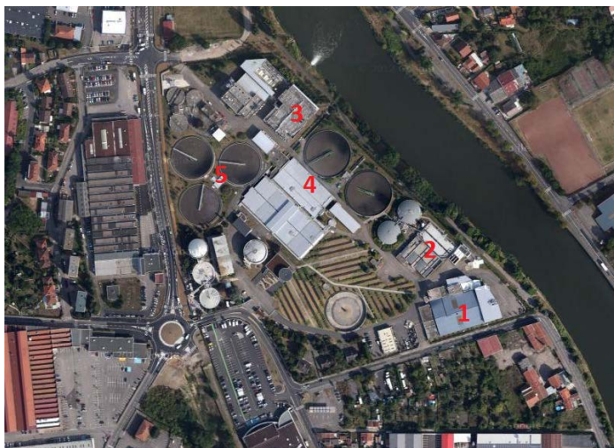
Figura 13 – Vista aérea da ETE Nancy Maxéville (1: Pré-tratamento, 2: Tanques de aeração, 3: Reator de leito fluidizado, 4: Tanques anóxicos, 5: Decantadores)
