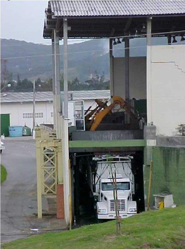
Figura 7 - Vista lateral da ETRS da Comcap
