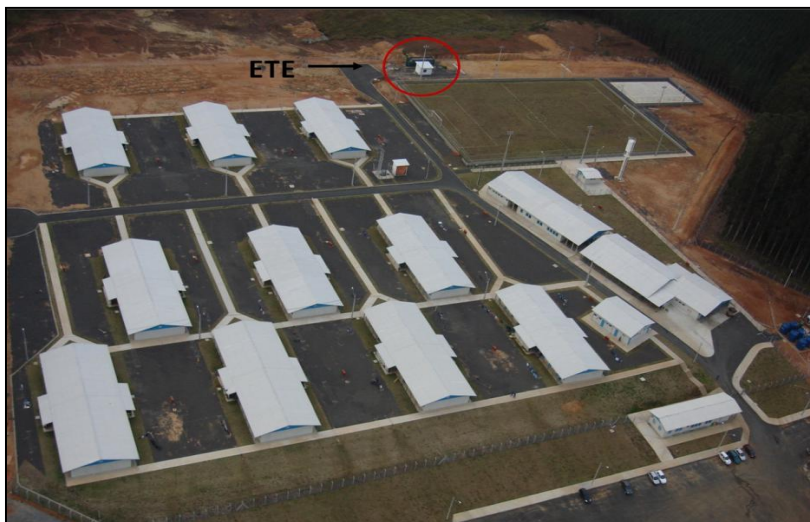
Figura 7 – Foto aérea do alojamento. Fonte: Rigesa, 2012.
