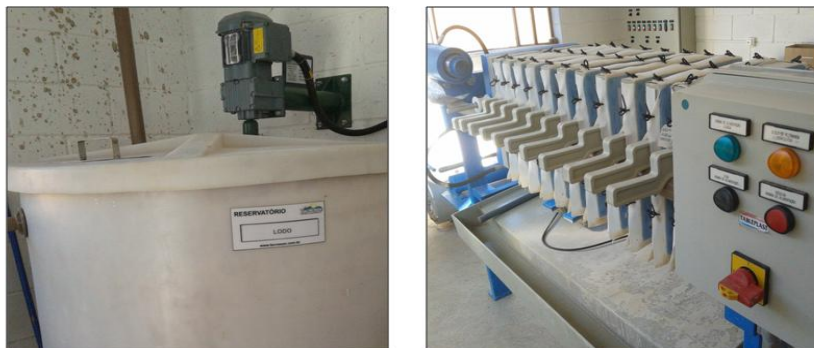
Figura 13 - Tanque para armazenamento do lodo excedente (esquerda) e Filtro Prensa para desaguamento do lodo (direita).
