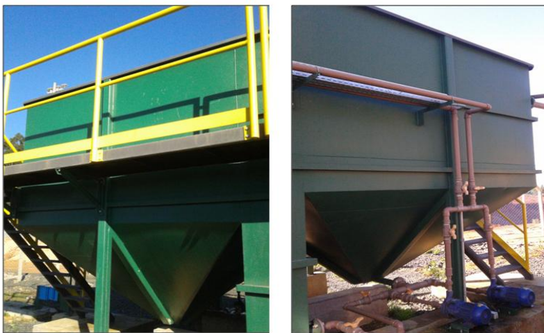
Figura 12 - Decantador secundário (esquerda) e bombas de recirculação do lodo (direita).
