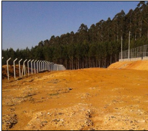
Figura 15 - Área da Vala de Infiltração.
