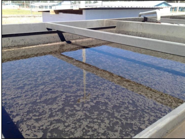
Figura 29 - Desprendimento de lodo do fundo do decantador secundário.
