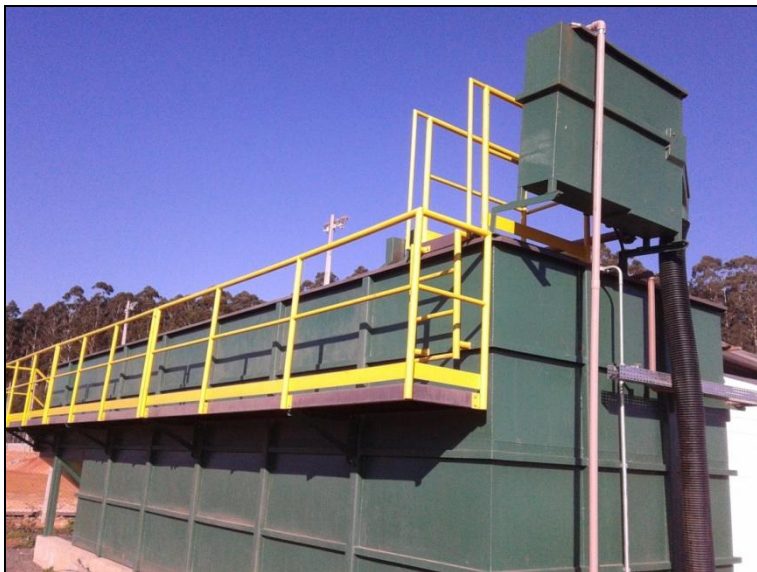
Figura 9 – ETE compacta – Tratamento Secundário.
