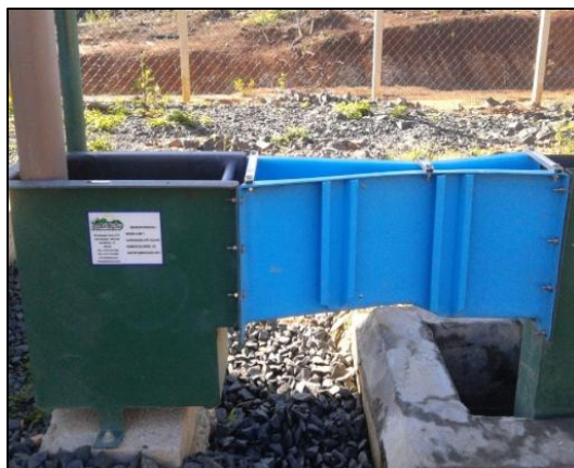
Figura 14 - Calha Parshall na saída da estação de tratamento.
