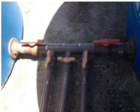
Figura 16 – Detalhe dos registros de saída da caixa d'água. Fonte: Elaborado pelo autor.
