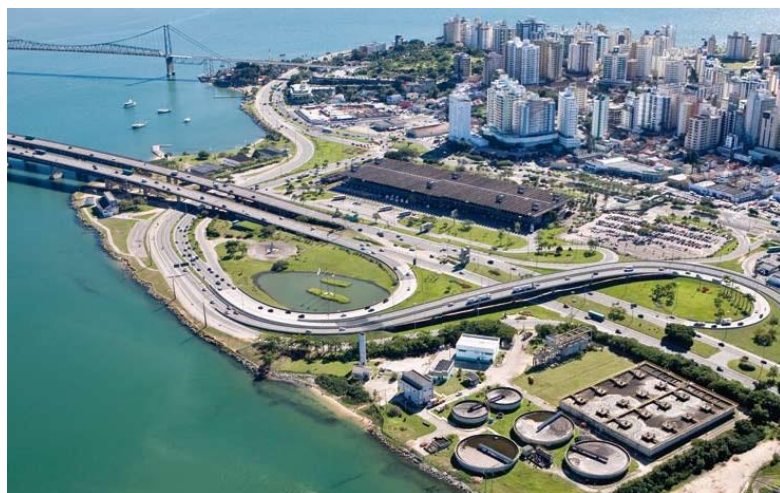
Figura 7 – Localização da ETE Insular. Fonte: CASAN.
