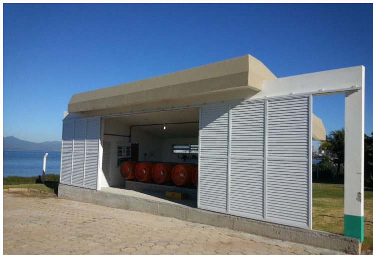
Figura 8 – Casa de Cloro. Fonte: CASAN, 2014.
