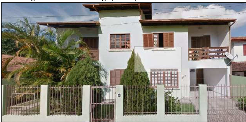
Figura 11- Casa com ligação suspeita de excesso de economias
