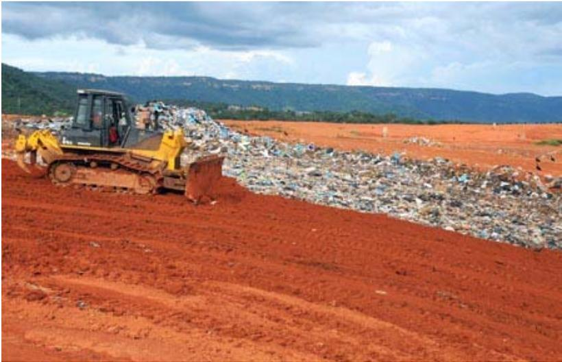
**Figura 5 – Aterro sanitário recebendo recobrimento.**
