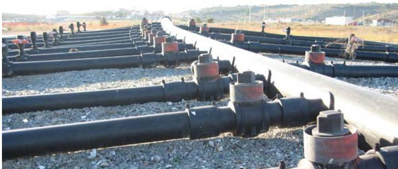
**Figura 2 - Sistema de drenagem e queima de biogás. Fonte: VALORSUL, 2011.**
