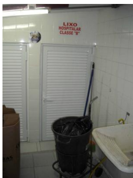
Figura 13 - Armazenamento temporário interno de resíduos infectantes
