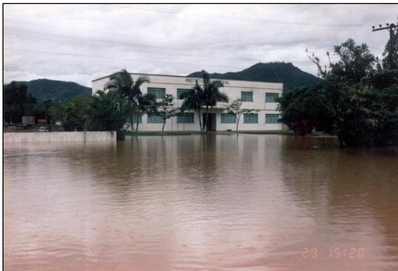
Figura 5.12: Prefeitura de Rio dos Cedros - Inundação de 1992
