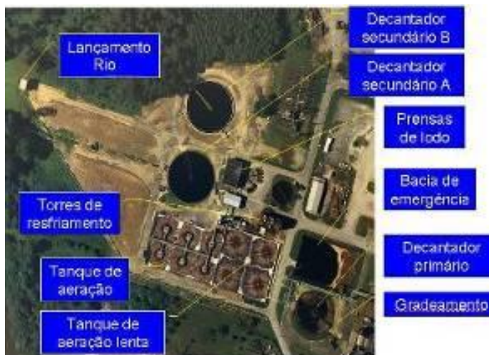
Figura 4 – Estação de Tratamento de Efluentes da empresa.
