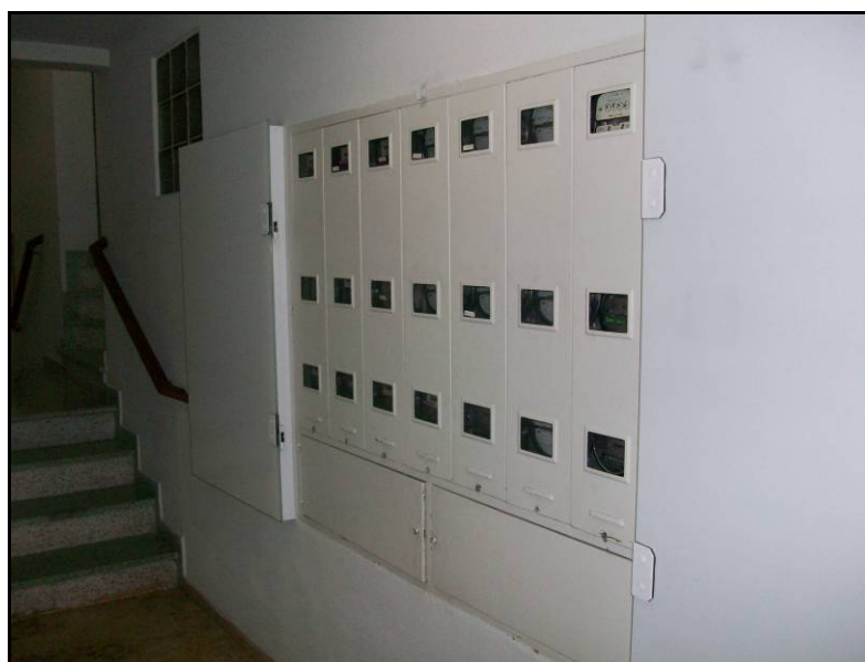
Figura 13. Disposição geral dos “relógios de luz” dos apartamentos do edifício
