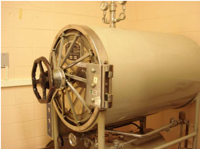
Figura 23 - Autoclave Utilizada no Tratamento Interno
