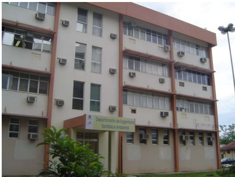
Figura 9- Vista frontal do prédio do Departamento de Engenharia Sanitária e Ambiental da UFSC.
