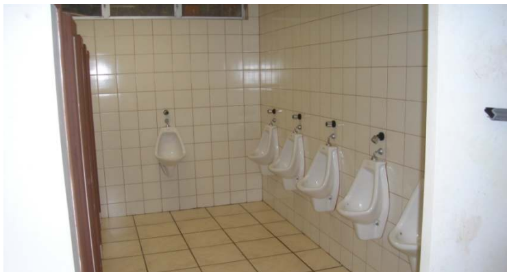
Figura 12- Vista geral do banheiro masculino do segundo pavimento. O banheiro masculino do quarto pavimento é idêntico a este.
