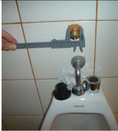
Figura 15- Medição com paquímetro do corpo do registro dos mictórios para verificação da bitola da tubulação
