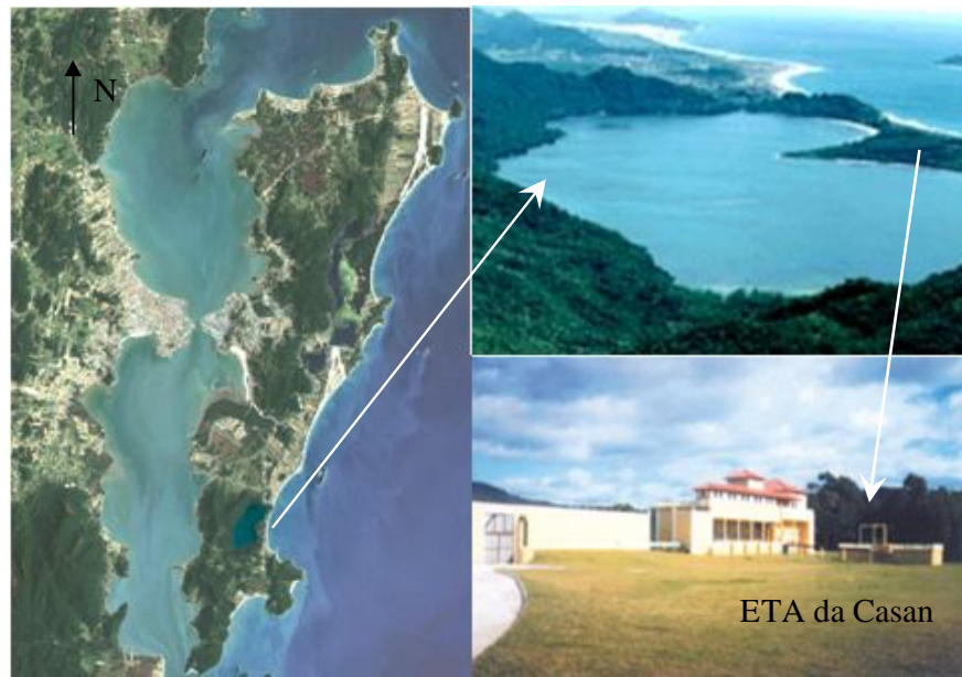
Figura 4.1 - Local de implantação do sistema piloto de filtração direta com filtros autolimpantes.
