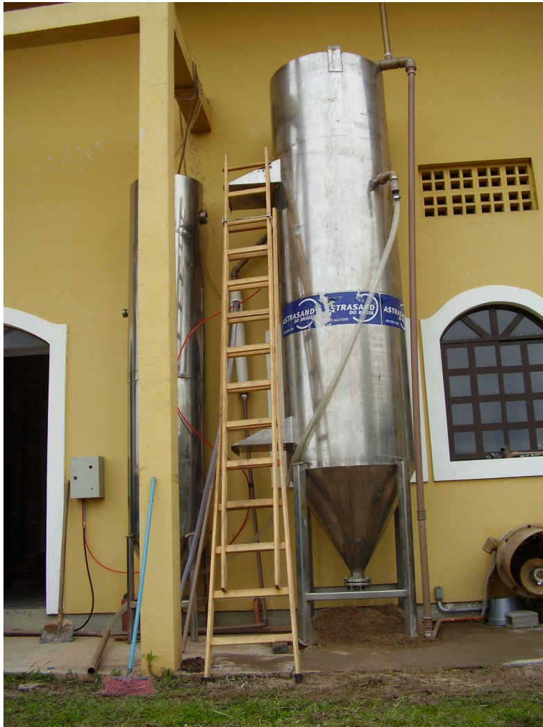
Figura 4.2 - Foto do filtro autolimpante utilizada na pesquisa.
