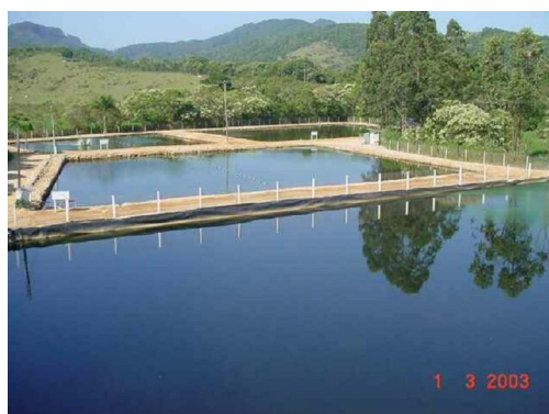
Figura 3 - Sistema de lagoas de estabilização do aterro sanitário de Biguaçu. (Fonte: Proactiva Meio Ambiente Brasil Ltda).
