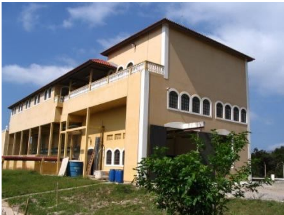
Figura 9.1 - Laboratório de Águas da Lagoa do Peri (LALP) na ETA, CASAN
