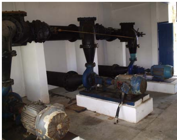
Figura 4.3 – Sistema de Bombeamento na Captação de Água. Fonte: O Autor.
