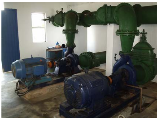
Figura 4.6 - Conjunto Motobomba da Estação de Recalque de Água Tratada - Balneário Rincão. Fonte: O Autor.
