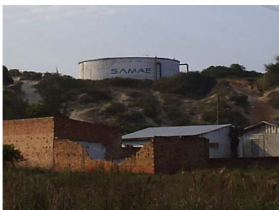
Figura 4.7 – R.D.A. (Reservatório de Distribuição de Água Tratada Apoiado). Fonte: O Autor.
