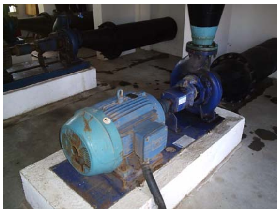
Figura 4.4 – Conjunto Motobomba em Operação na Captação de Água. Fonte: O Autor.
