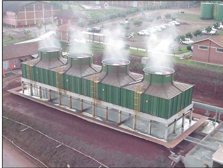
Figura 17 – Torre de Resfriamento de Água.
