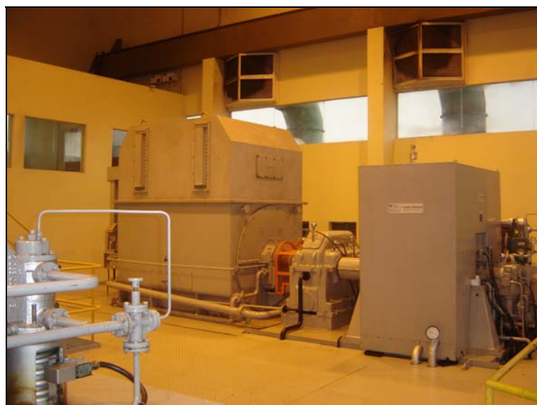
Figura 18 – Turbo Gerador Toshiba em operação.
