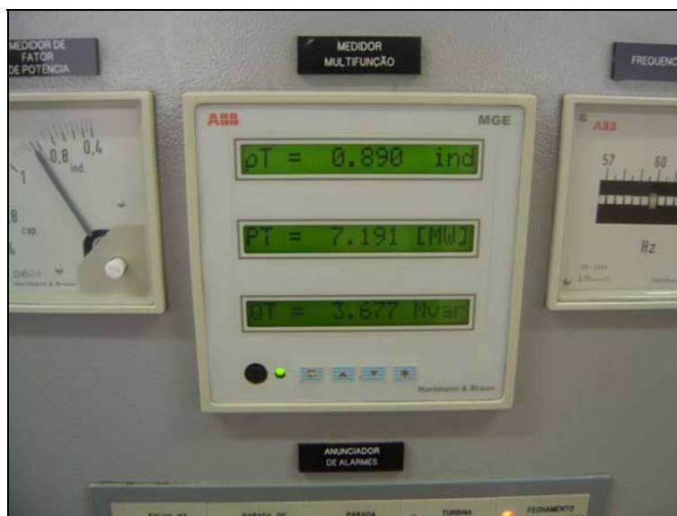
Figura 19 – Painel do Gerador indicando a energia gerada (7.191 MW).
