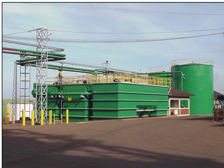
Figura 14 – Estação de Tratamento de Água (ETA Usina São Luiz)
