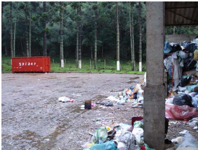
Figura 40: Pátio de manobra e início do pátio de recebimento
