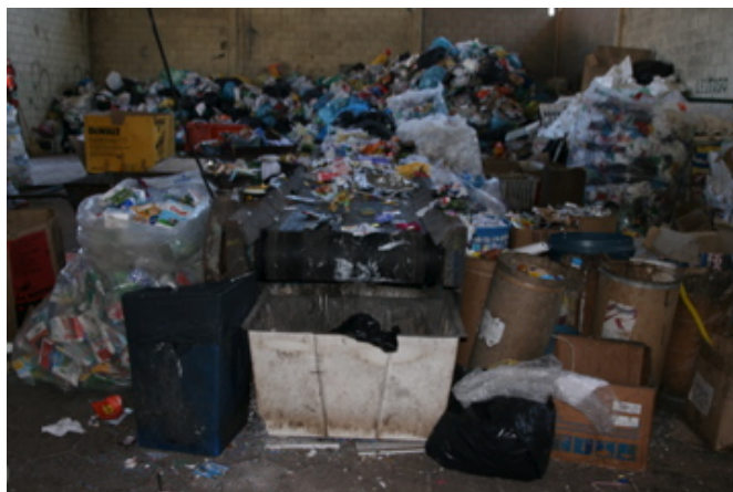
Figura 31: Final da esteira de triagem com coletor de rejeitos
