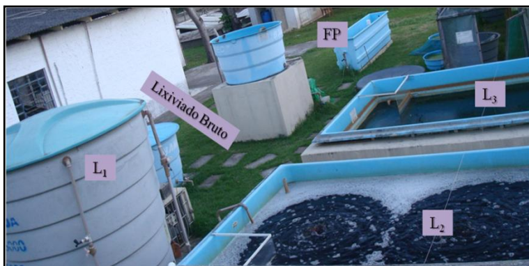
Figura 4 - Sistema piloto tratamento biológico (2009).
