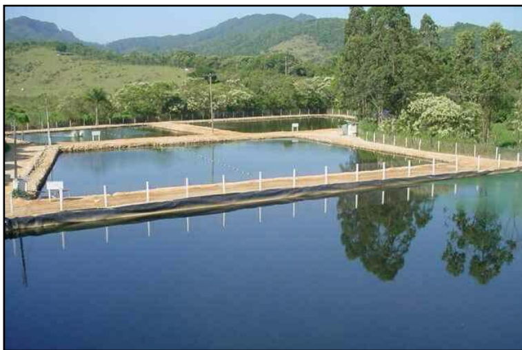
Figura 3 - Sistema de lagoas de estabilização do aterro sanitário de Biguaçu.
