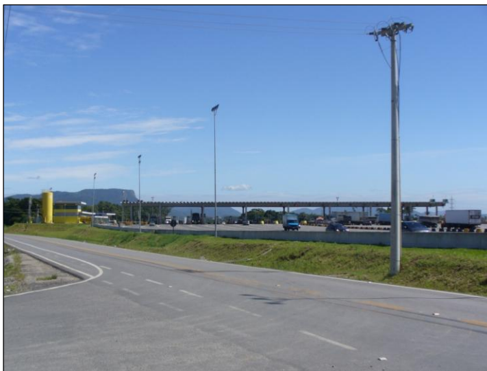
Figura 3 – Praça de Pedágio, Km 221.
