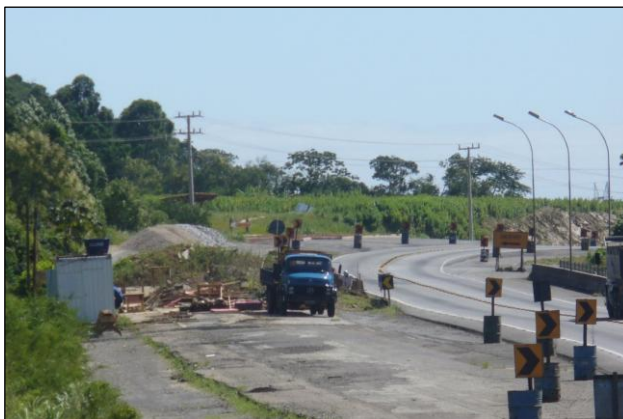
Figura 5 – Canteiro de Obras e Insumos Para a Construção da Ponte.
