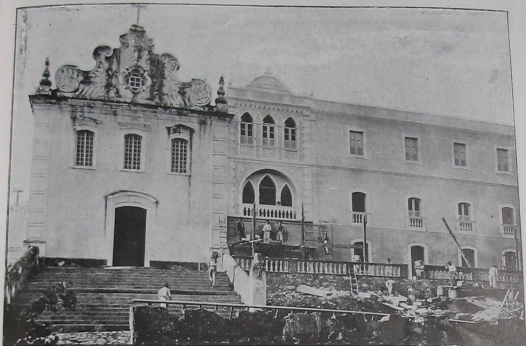
Collegio N. S. Auxiliadora, em obras, 1911. Foi reconstruido para ahi ser fundado o Asylo «Coração de Jesus»
