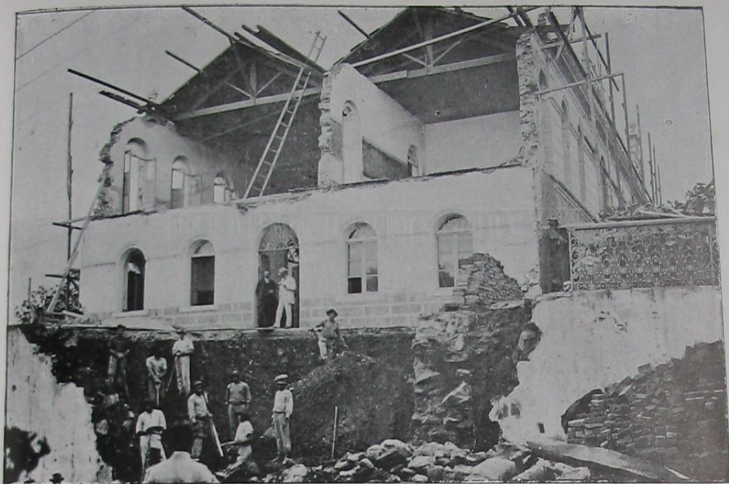
Escola Modelo em reconstrução. Victoria 1912 (lado da ladeira do Palacio).
