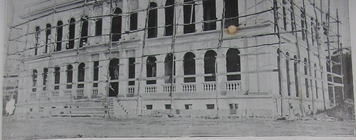
Grupo escolar de Cachoeiro de Itapemirim, em construção. 1912
