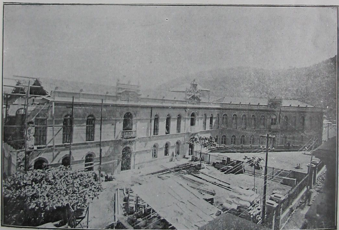
Escola Modelo em 1912, (lado do Palacio do Governo). (Vê-se que a construção está sendo concluída).
