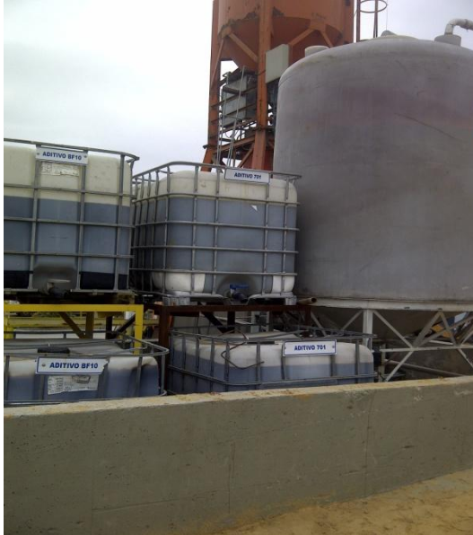
Figura 2.8 – Armazenamento de aditivos em central de concreto
