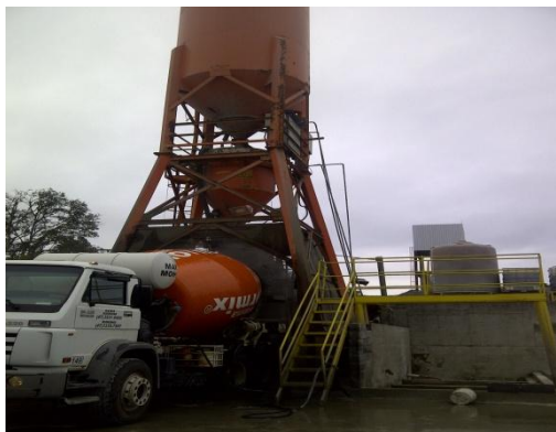
Figura 2.5 – Carregamento do caminhão-betoneira em uma central de concreto
