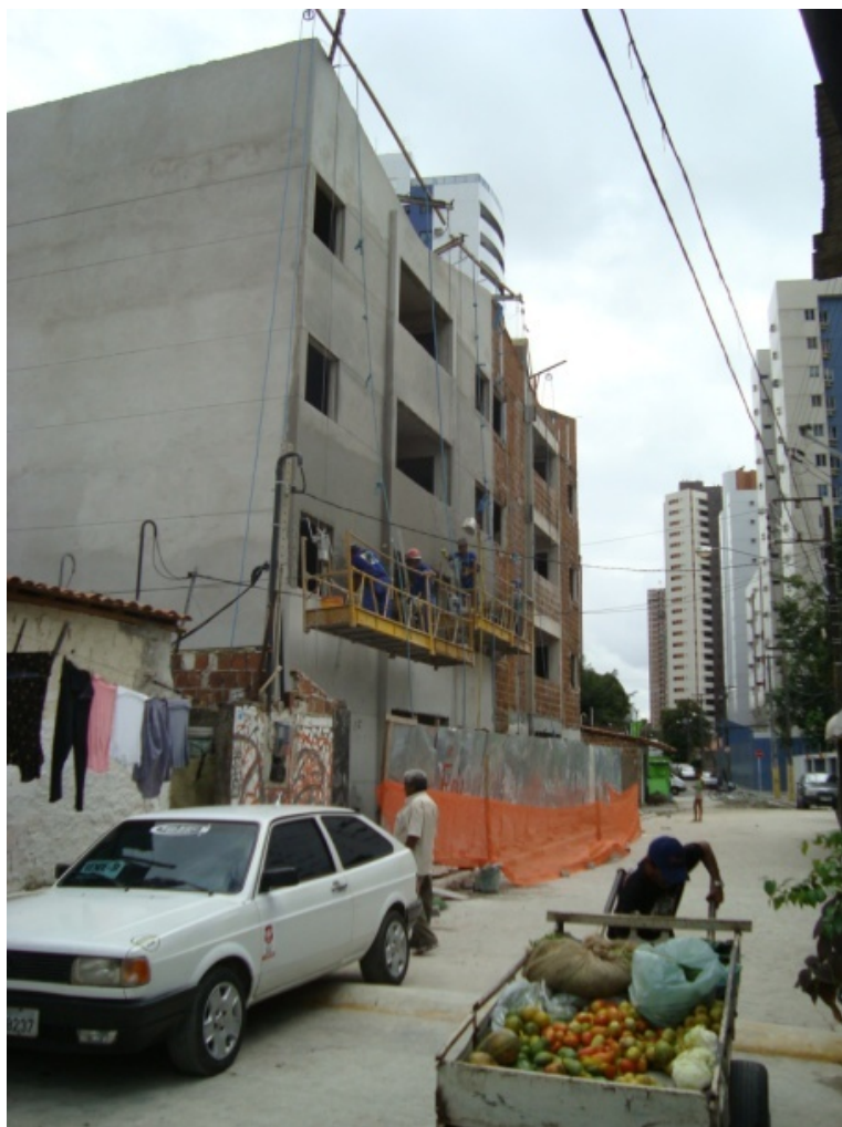
Figura 13 – Fotografia do aspecto das vias internas pavimentadas e construção de novo bloco de apartamento (habitacional)
