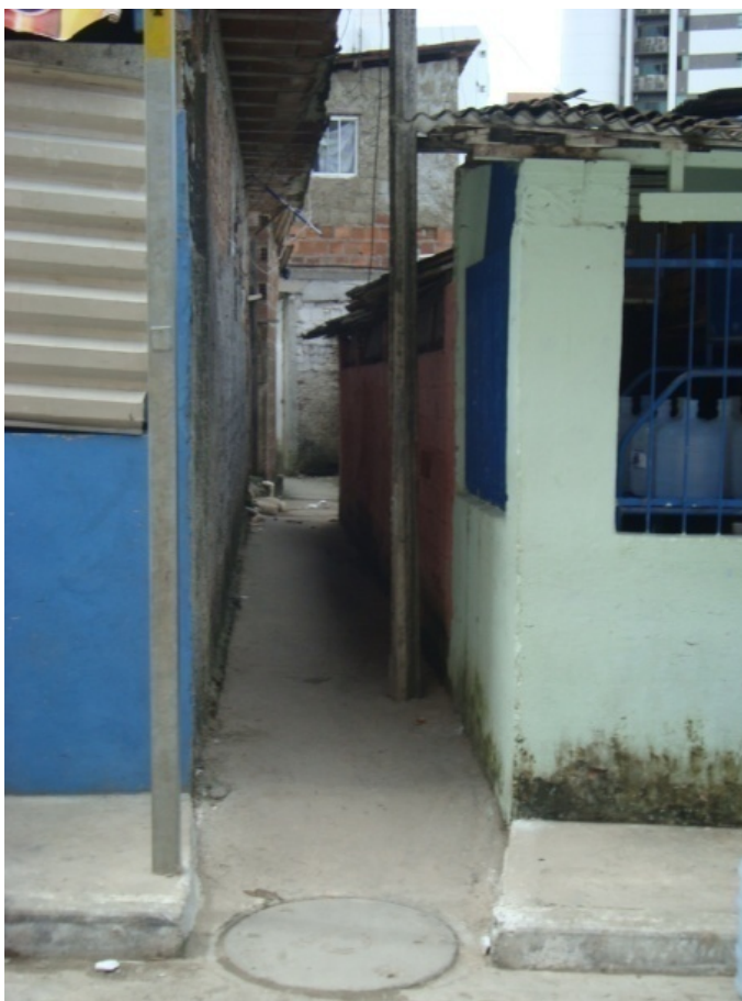
Figura 14 – Fotografia do aspecto das vias internas (becos)
