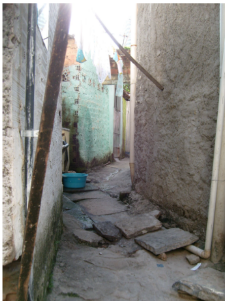
Figura 15 – Fotografia do aspecto das vias internas anterior às intervenções.
