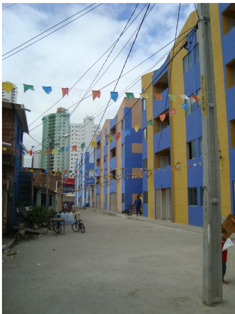
Figura 8 – Fotografia do habitacional multifamiliar
