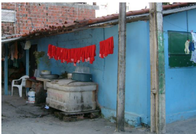
Figura 22– Fotografia da estocagem de água em reservatórios de amianto
