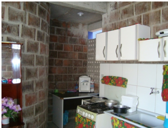
Figura 11 – Fotografia do aspecto interno de apartamento no habitacional ocupado sem melhorias.
