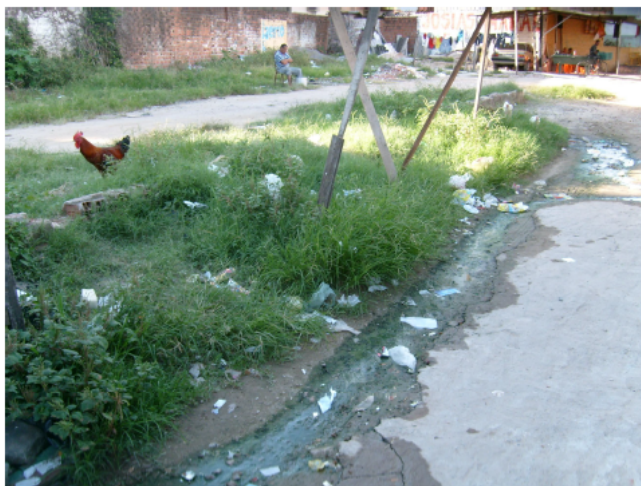
Figura 16 – Fotografia do aspecto das precárias condições de salubridade existentes anteriormente.
